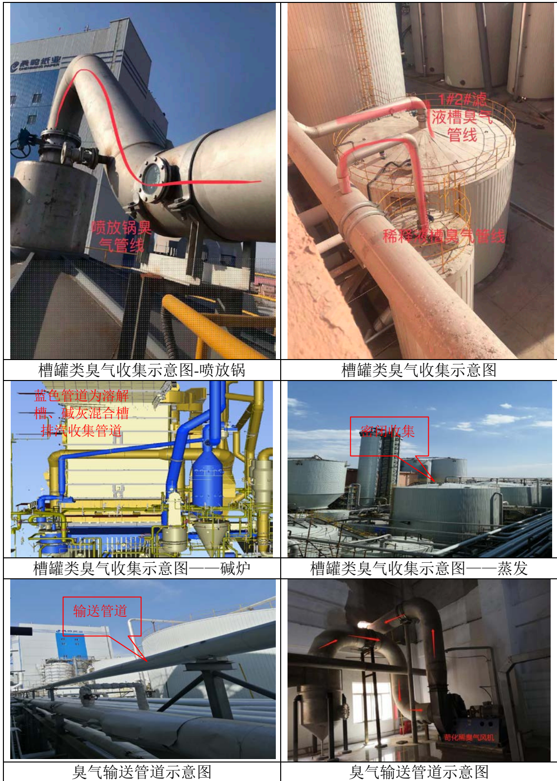
图 4.4-3 臭气收集输送系统示意图
