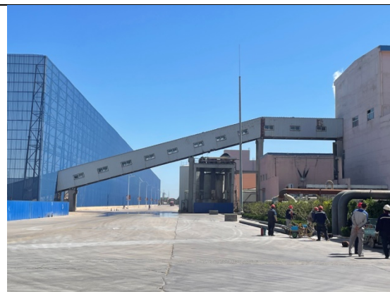
原料堆场输送木片至备料间
