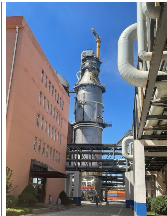
制浆车间蒸煮塔
