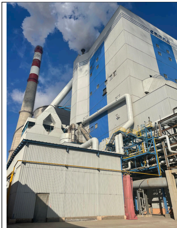
碱炉及排气筒
